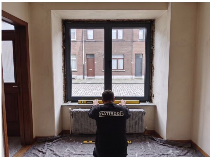
Calage et mise à niveau
