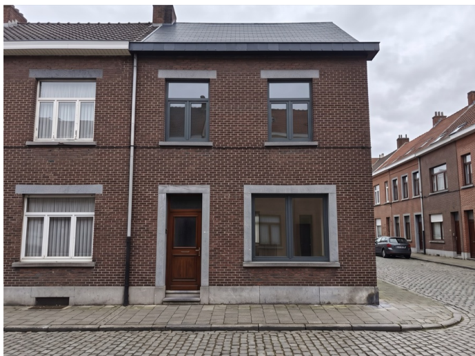
Façade après travaux
