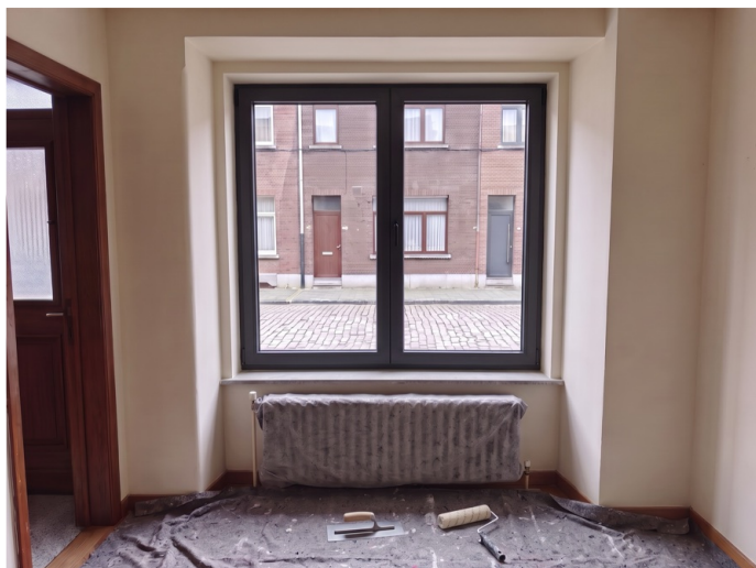
Ébrasement replâtré et repeint
