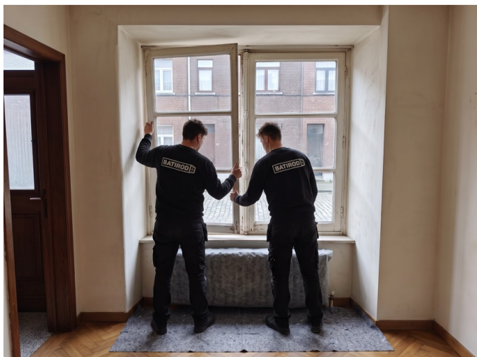
Dépose des ouvrants
