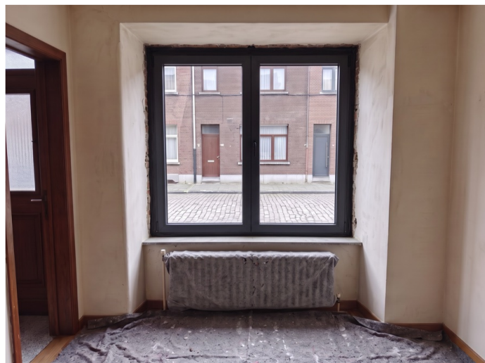
Châssis fixé, avant les finitions
